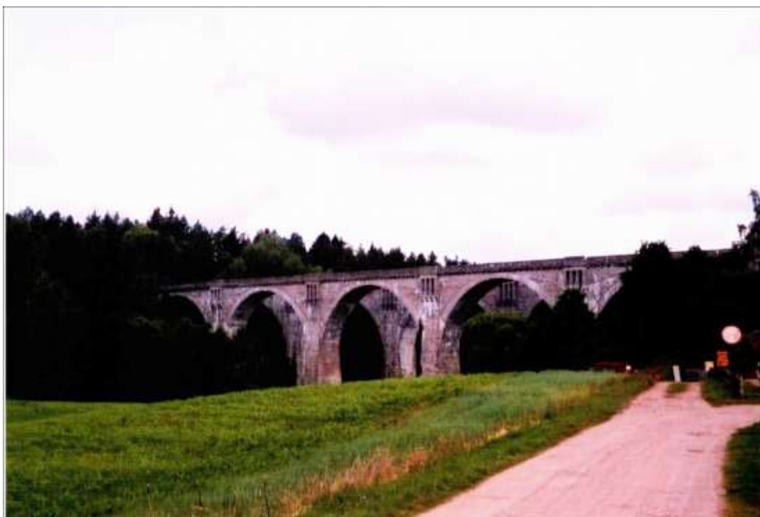
Wiadukty kolejowe w Stańczykach - czerwiec 2008
