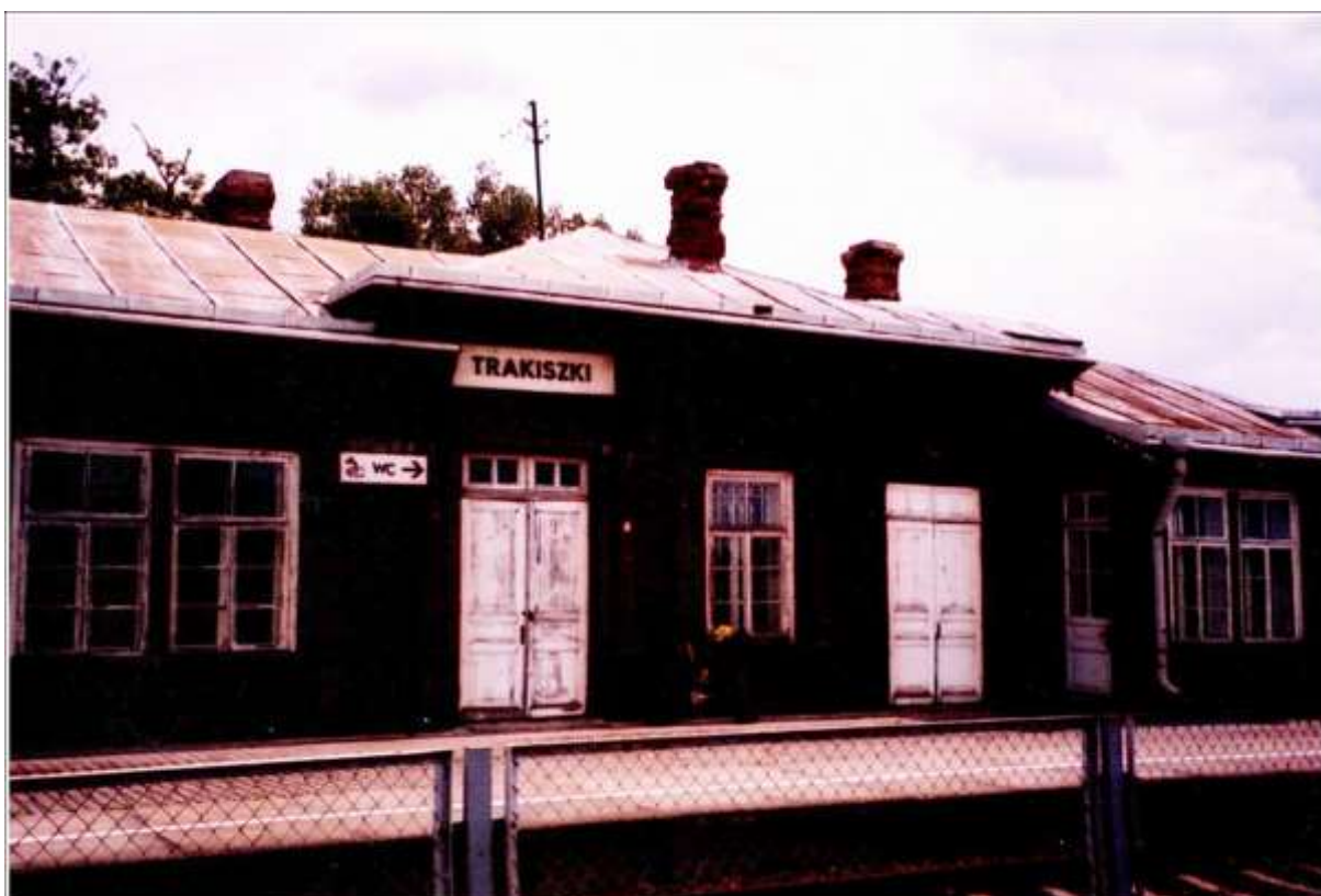
Dworzec kolejowy w Trakiszkach - czerwiec 2008 (przed przebudową)
