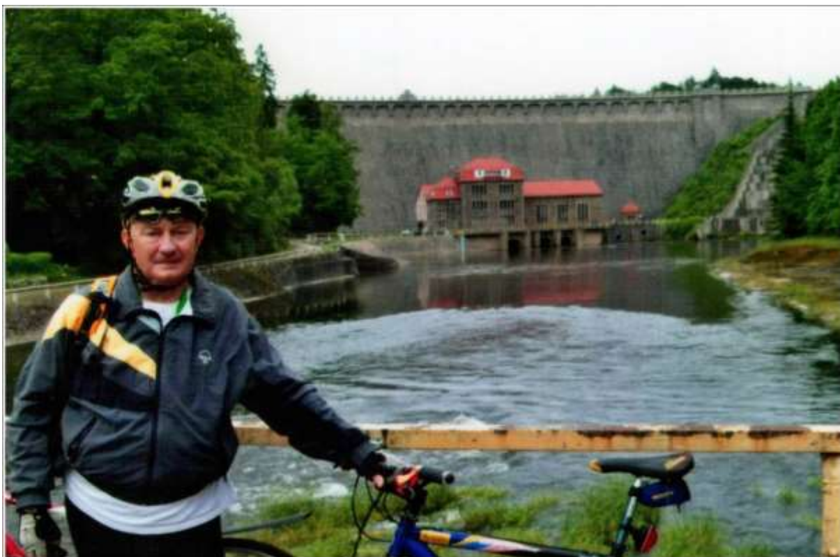
Zapora i elektrownia na rzece Bóbr w Pilchowicach - czerwiec 2010
