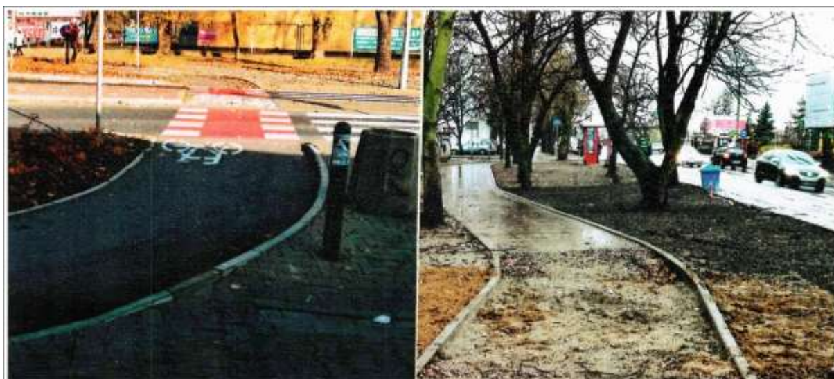
Migawki z budowy ścieżki rowerowej wzdłuż Warszawskiej w 2011 roku W listopadzie rozpoczęto układanie asfaltu, a 10 grudnia 2011 cały odcinek o dł. 1205m był gotowy.
